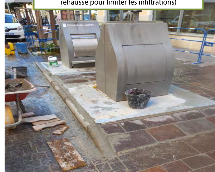
Après travaux - Rue Fontvieille à Antibes (pose de réhausse pour limiter les infiltrations)
